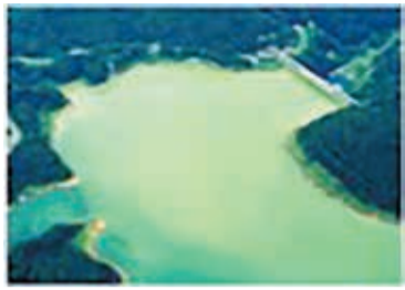
写真-1 ダム湖における植物プランクトンの異常増殖の様子(田瀬ダム湖:平成17年度時点) 出典:国土交通省北上川ダム総合管理事務所HP
